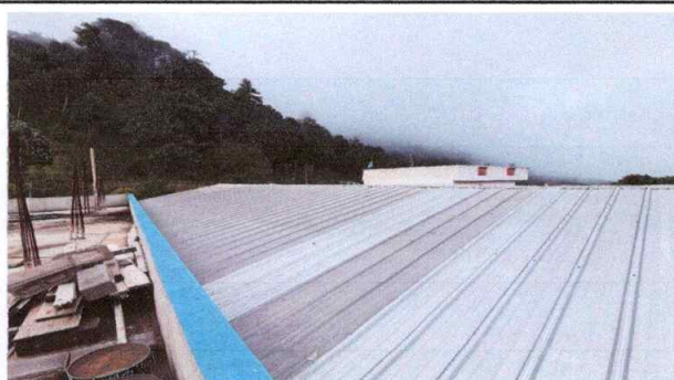
Foto 2: Sustitución de capote de lámina, para lámina troquelada, en tres aulas, baños y cocina escolar
