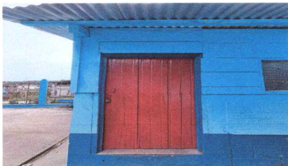
Foto 3: Sustitución de puerta de metal en cocina escolar
