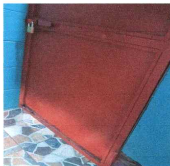
Foto 4: sustitución de puertas de metal en Baños
