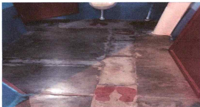
Foto 9: Sustitución de piso cerámico en baños
