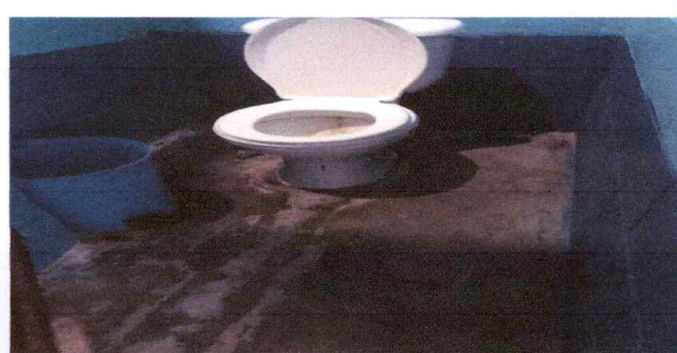
Foto 10: Sustitución inodoros en los baños
