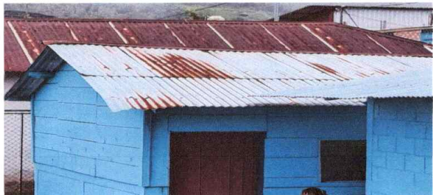
Foto 1: Sustitución de lámina, por lámina troquelada aluzinc calibre 26, en la cocina escolar
