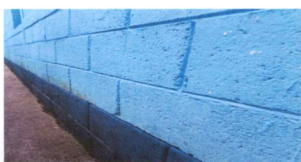
Foto 12: Sellado de grietas y fisuras en muros
