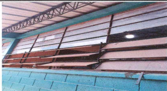
Foto 7: Sustitución de estructura de metal de ventanas en aulas
